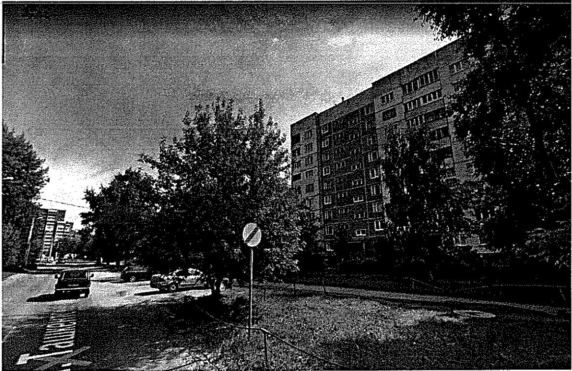
Многоэтажный жилой дом по адресу: ул. Ташкентская, 13
